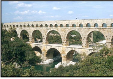
Pont du Gard aquaduct - Nîmes - 50 n. Chr.
